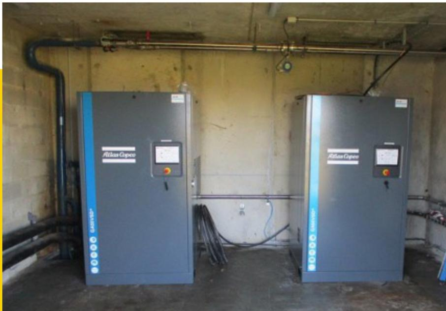
Nous avons procédé au remplacement des compresseurs de la zone de production, les nouvelles générations de compresseurs permettant une baisse de la consommation électrique de l'ordre de 25 %
